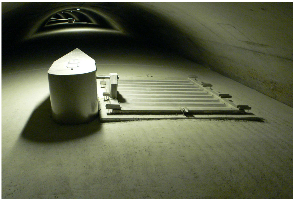
(Exemple d'une trappe d'air vicié)
